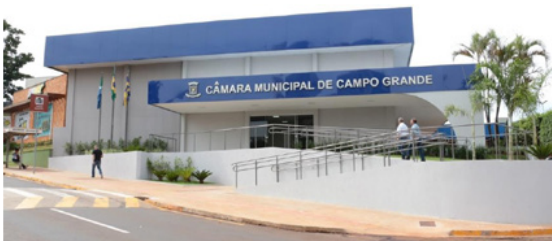
Foto depois da Reforma, com acessibilidade.
